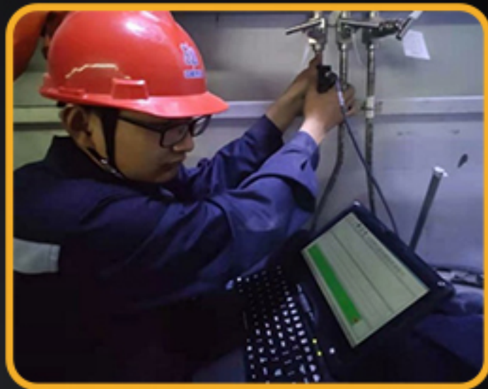
小径管检测 具备管道曲率及信号处理算法 支持小径管检测
